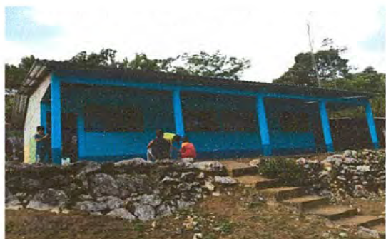
Foto 3: las puertas y los vidrios ya esta instalados
