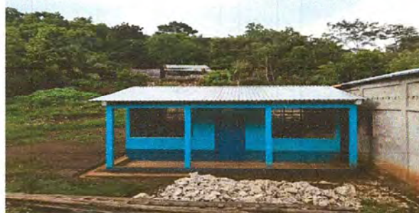
Foto 4: El techo y las pinturas del módulo 2
