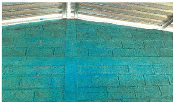
Foto1: El techo ya esta instalado
